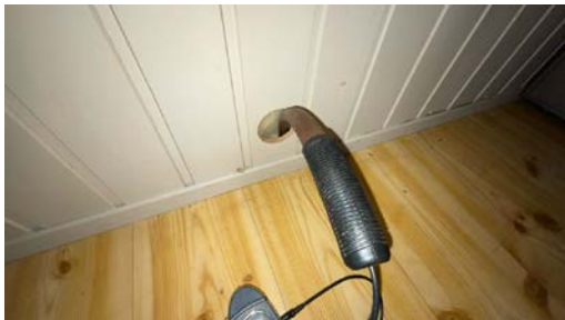
Hulltaking mot vaskerom.
