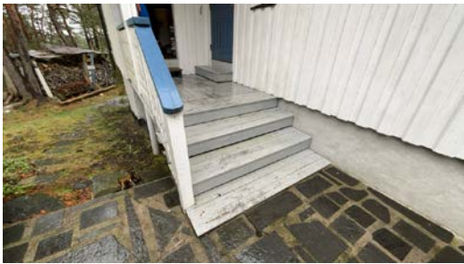
Utvendig trapp i tre.
