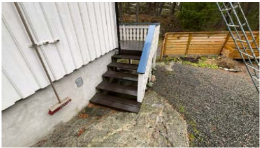
Utvendig trapp i tre.
