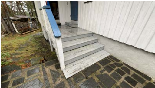
Utvendig trapp i tre.
