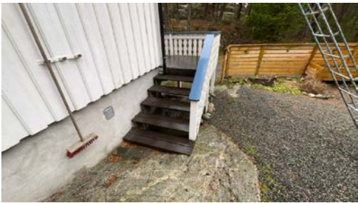
Utvendig trapp i tre.
