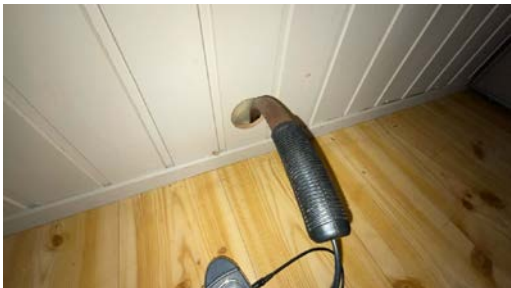
Hulltaking mot vaskerom.
