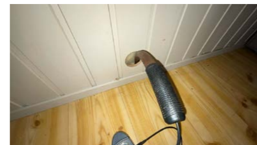
Hulltaking mot vaskerom.
