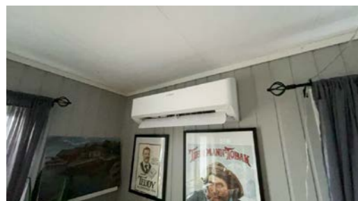
Varmepumpe, innvendig komponent.
