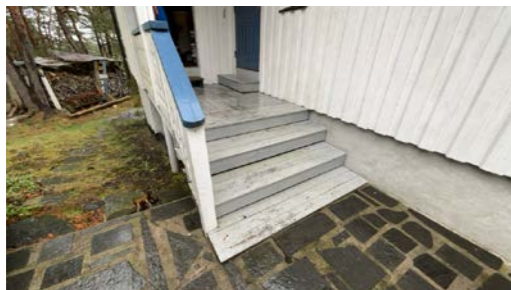
Utvendig trapp i tre.
