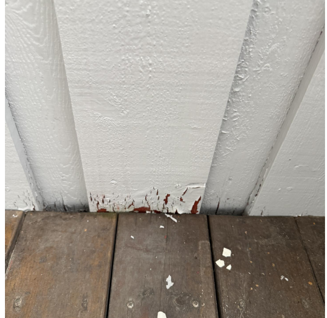
Flassing på innside av rekke.
