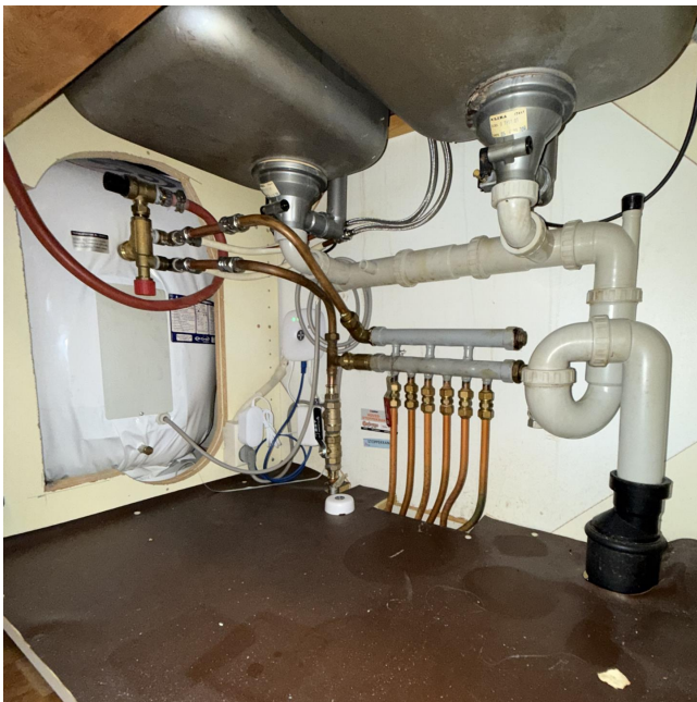
Bereider og stoppekran i kjøkkenskap.
