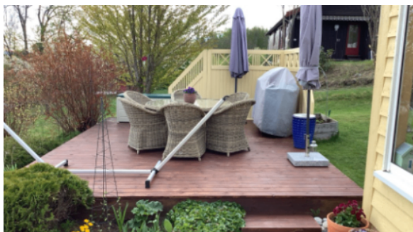
Frittliggende platting. Platting har løftet seg noe av telehiv.
