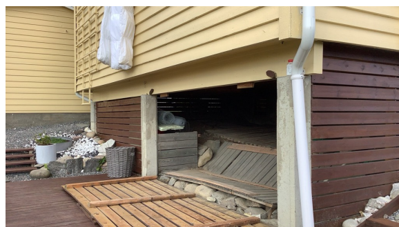
Tilbygg mot sør på betongpilarer.
