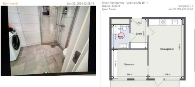
Måling høyde på topp slukrist Bad
