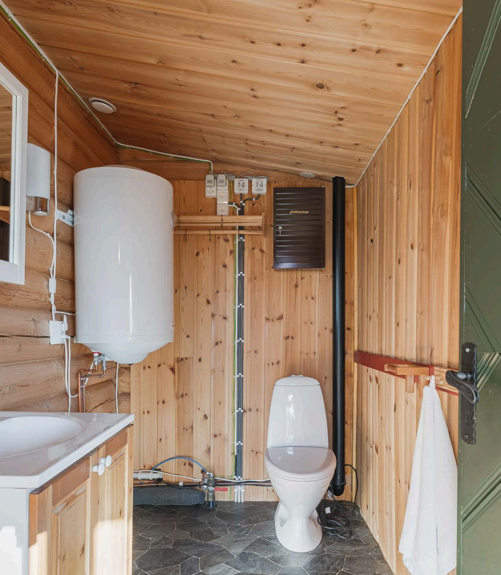
Fra gangen er det også adgang til et ekstra toalettrom med belegg på gulv. Toalettrommet er utstyrt med servantskap med speil over, gulvstående toalett og varmtvannsbereider.
