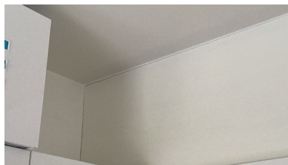
Enkelte sprekke-dannelser i hjørner der det er brukt gips i trehus må påregnes og anses som normalt.
