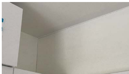
Enkelte sprekkdannelser i hjørner der det er brukt gips i trehus må påregnes og anses som normalt.
