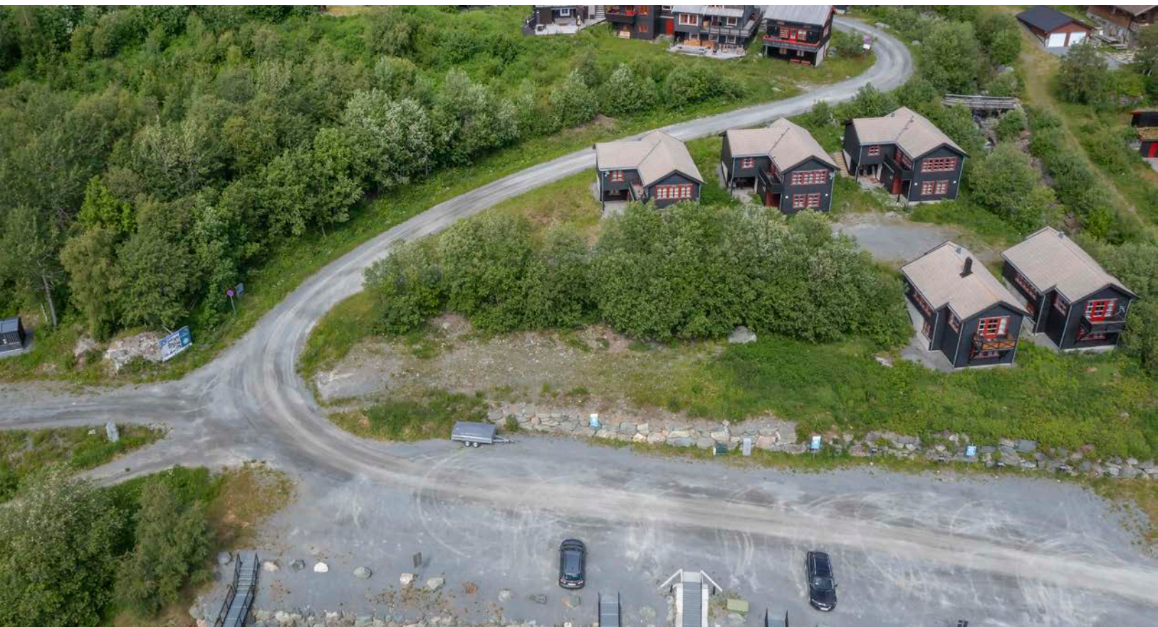
Oversiktsbilde som viser både felt 1 og 2
