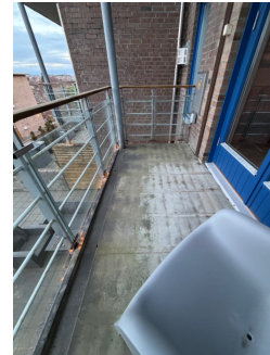
Balkong i betong med adkomst fra stue.
