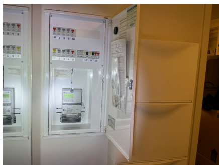
Sikringsskap står i entre/gang.
