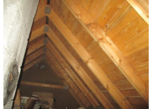
Takstoler med rupanel som undertak.
