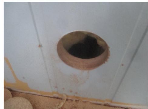
Hulltaking i utfored vegg i kjeller.
