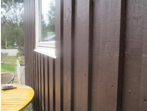
Deler av kledningen med tilhørende belistninger.
