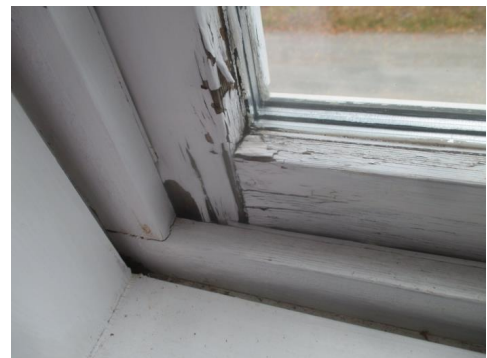
Innvendige fuktskader.
