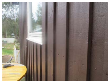
Deler av kledningen med tilhørende belistninger.
