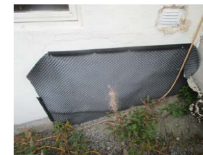
Deler av fuktsikringen.
