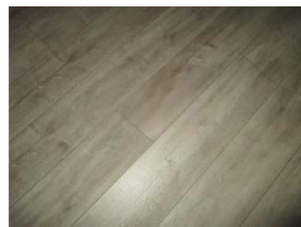
Laminatgulv i allrom buler. (større bevegelse)
