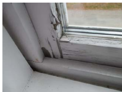
Innvendige fuktskader.
