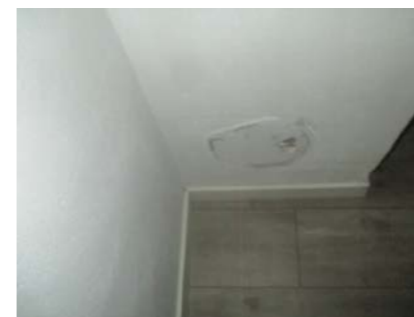
Sotluke i kjeller.
