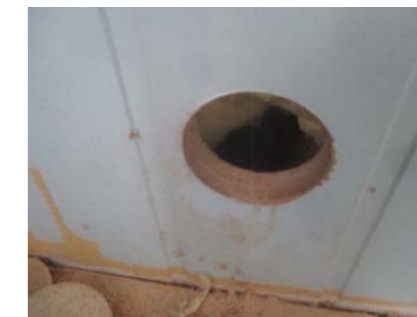
Hulltaking i utfored vegg i kjeller.
