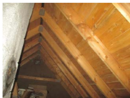
Takstoler med rupanel som undertak.
