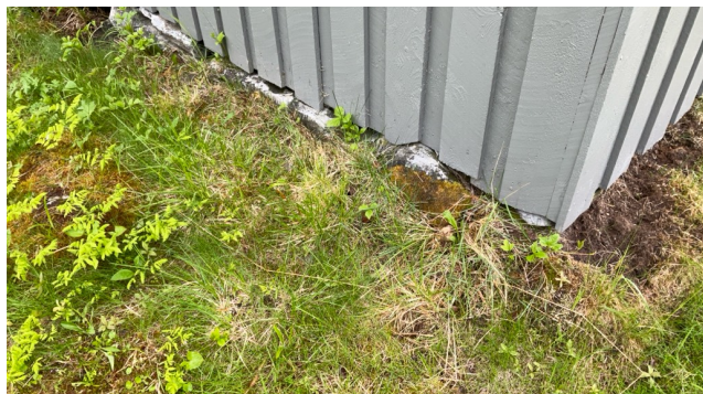
Kledning er for nære bakken.
