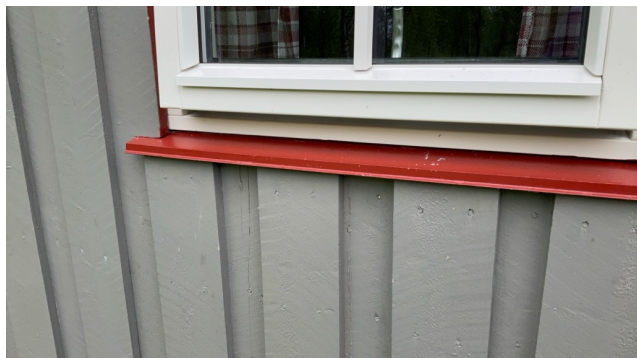
Karmbord er plassert helt ned på beslag.
