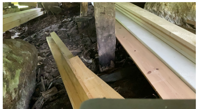
Pilarer fundamentert på bakken.
