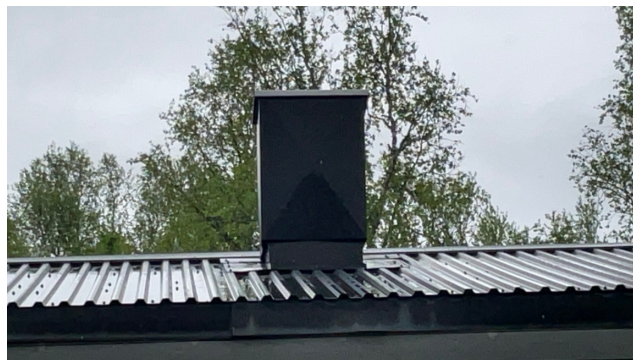
Heldekkende pipebeslag.
