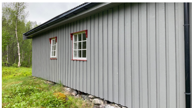
Vegg mot nord.
