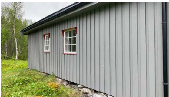
Vegg mot nord.
