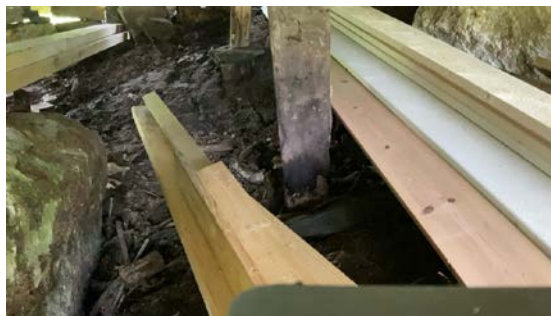
Pilarer fundamentert på bakken.
