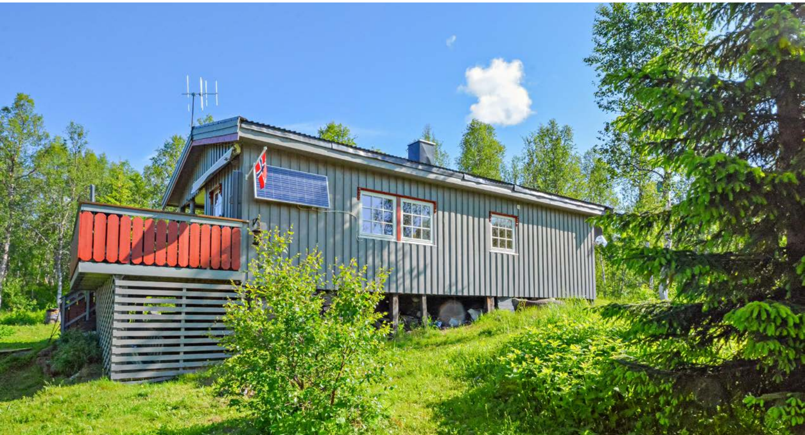
Fasade av hytten mot sør
