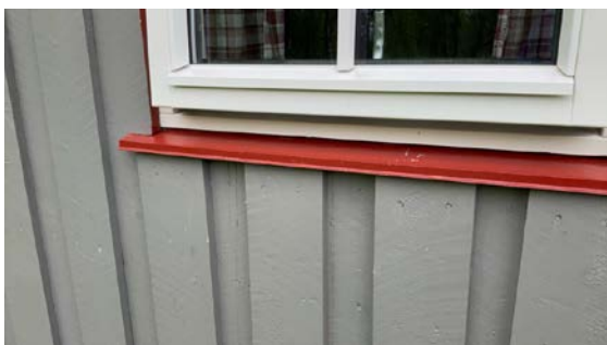
Karmbord er plassert helt ned på beslag.
