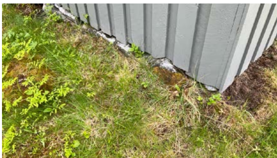
Kledning er for nære bakken.
