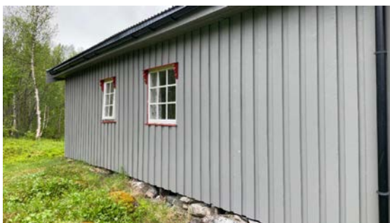
Vegg mot nord.
