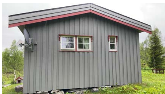
Vegg mot øst.
