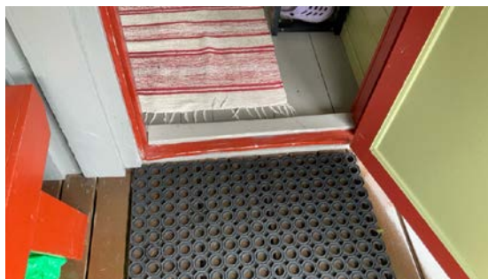
Manglende pakninger i karm og beslag under terskel.
