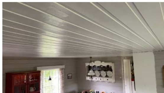
Synlig nedbøying i himling på stue
