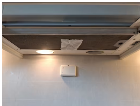
Kjøkkenventilator er testet med papir.
