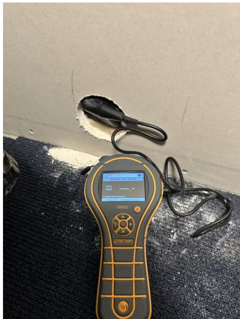
Bilde fra fuktmåling i veggkonstruksjon tilstøtende våtsone.
