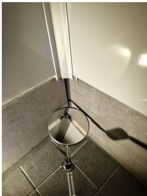
Åpning under hjørnelist i våtsone.
