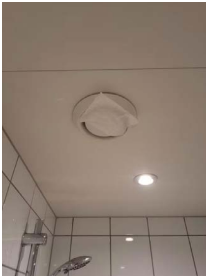
Avtrekkseffekt er testet med papir.
