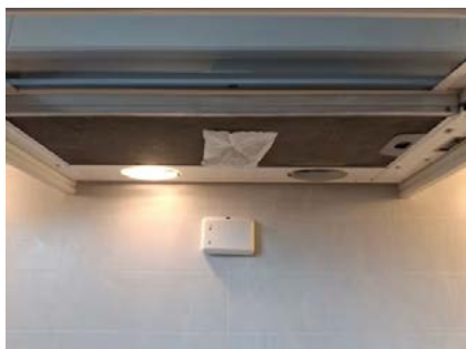
Kjøkkenventilator er testet med papir.
