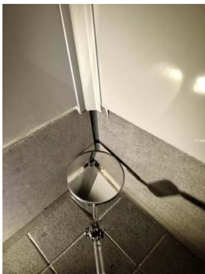
Åpning under hjørnelist i våtsone.
