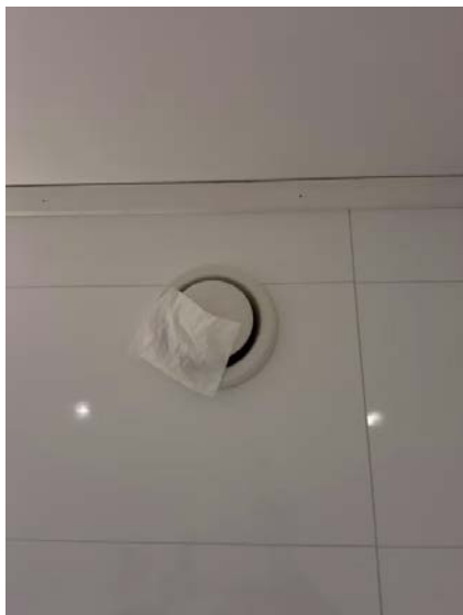
Avtrekkseffekten er testet med papir.
