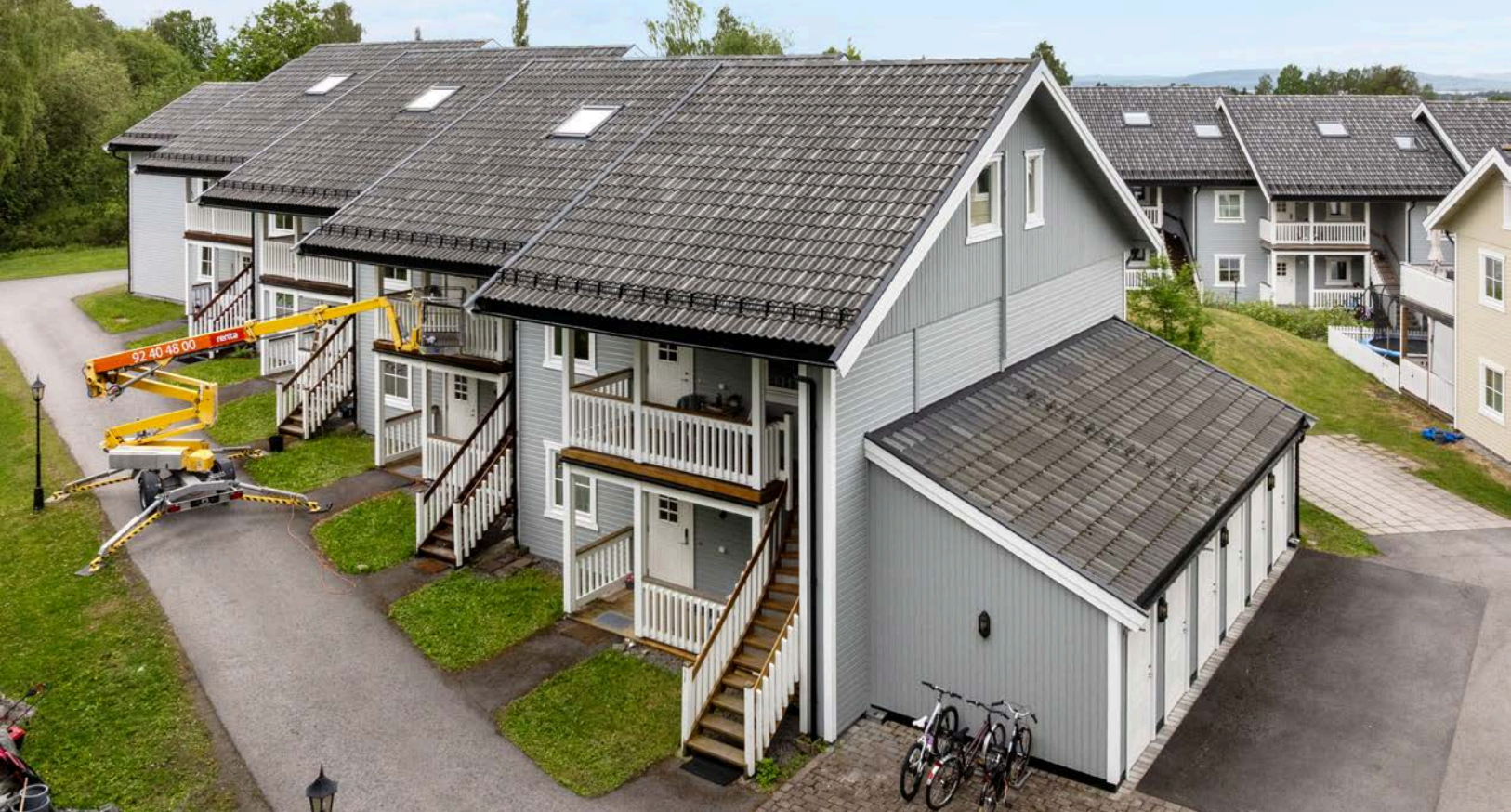
Leiligheten ligger på enden i 2. etasje og med innredet loftetasje.
