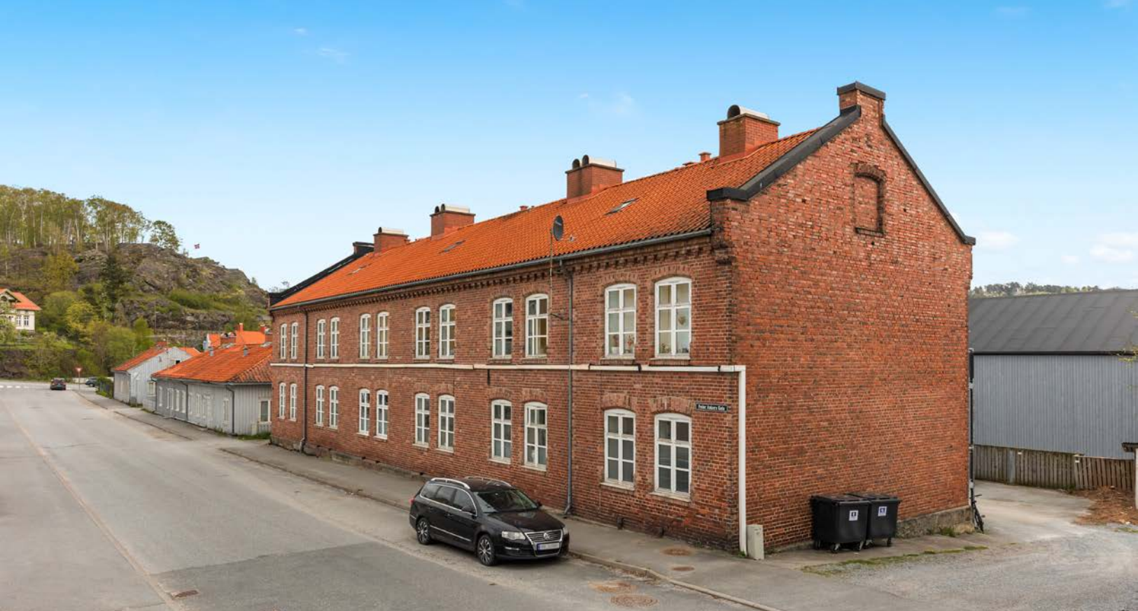
Sameiet består av en bygning over 2 etasjer + loft og kjeller.
