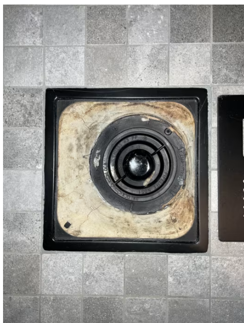
Viser sluk i dusjsonen.
