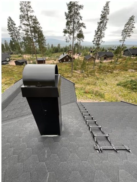
Viser helbeslått pipe over tak og takstige.
