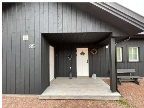
Viser overbygget platting ved inngangsparti mot øst.
