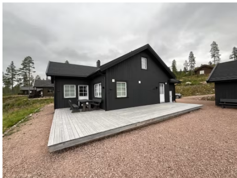
Viser terrasse med adkomst fra stue, vaskerom og terreng. Vendt mot sør/vest.
