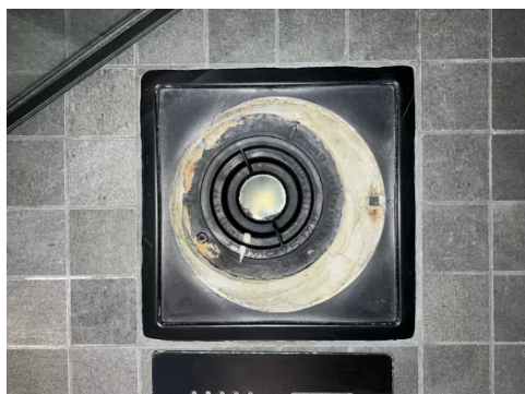
Viser slukløsning i dusjsonen.
