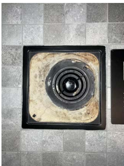
Viser sluk i dusjsonen.
