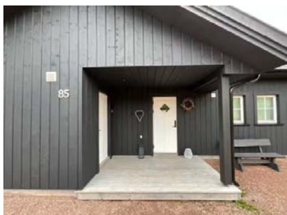
Viser overbygget platting ved inngangsparti mot øst.
