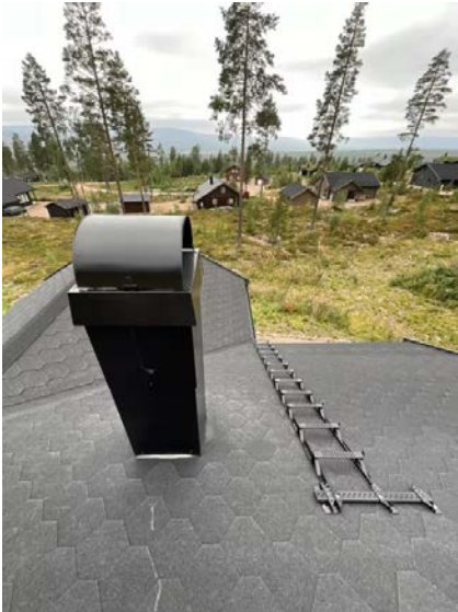
Viser helbeslått pipe over tak og takstige.
