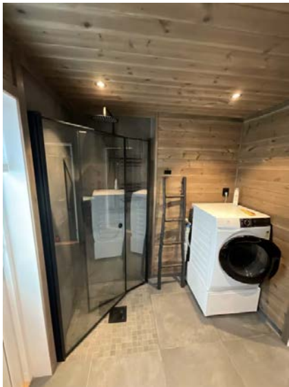
Viser dusjsone og opplegg for vaskemaskin.
