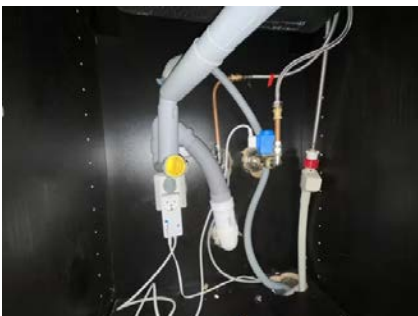
Viser vann og avløpsinstallasjoner under kum.
