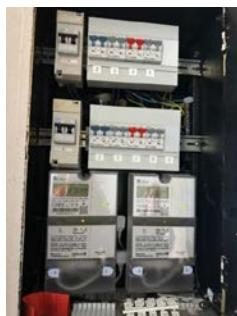
Sikringskap med automatsikringer.
