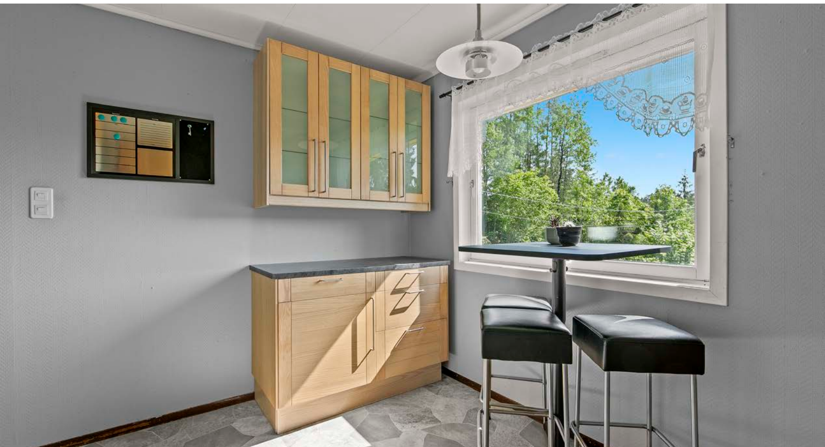
Kjøkkeninnredning med glatte, folierte fronter og laminert benkeplate.
