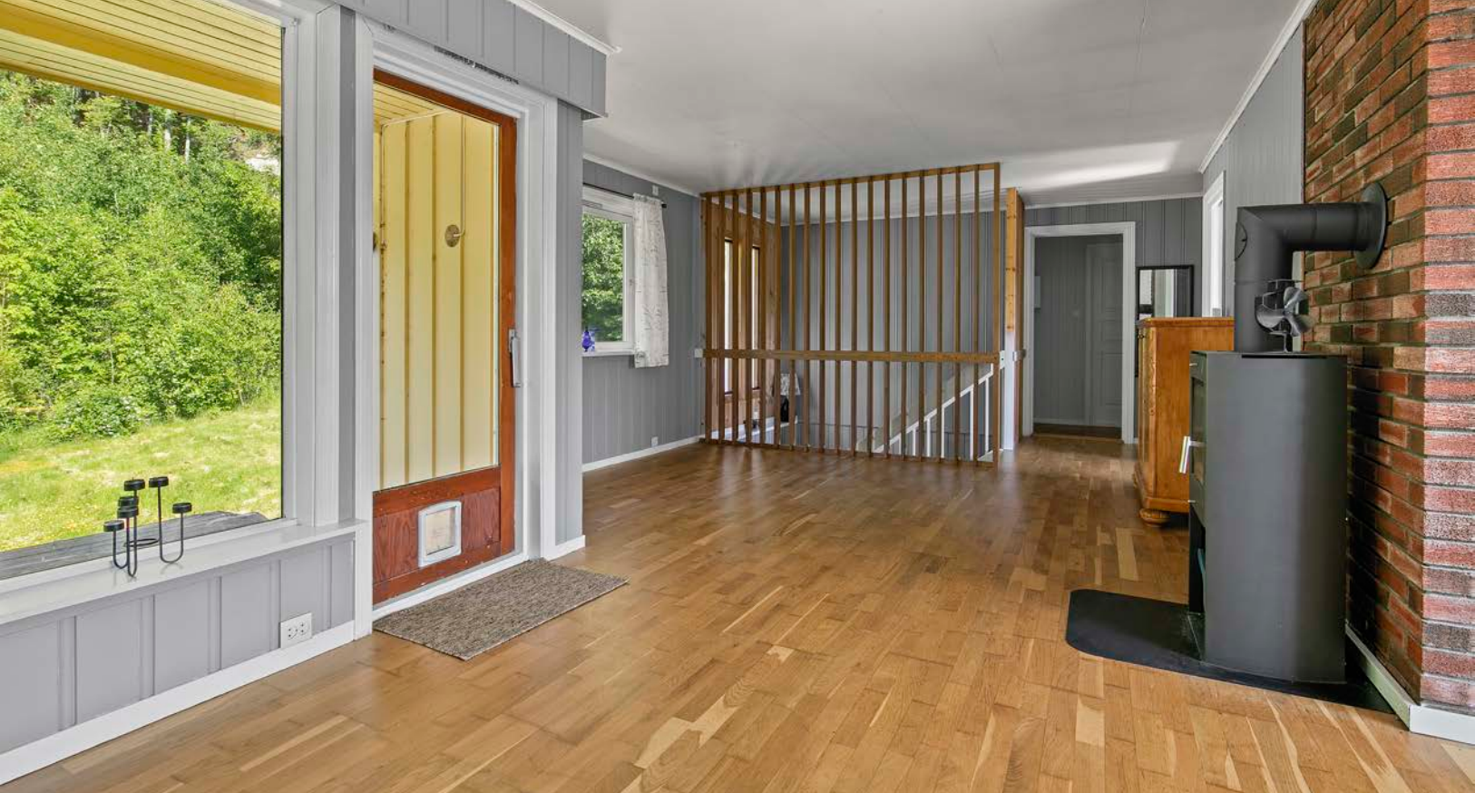
Herfra er det adgang til nord-vendt terrasse med kveldssol. Deler av terrassen er revet i forbindelse med planlagt ny terrasse. Resterende terrasse må også byttes.
