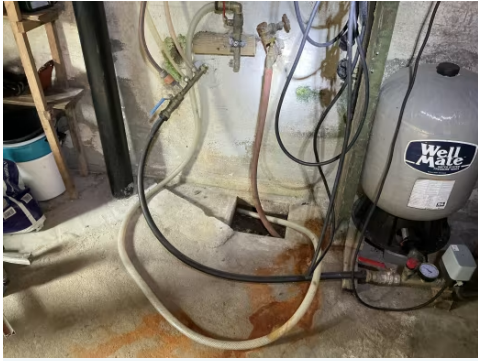
Vannledninger henger løst.
