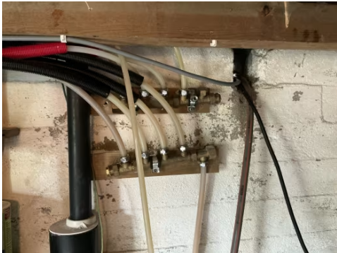
Vannledninger henger løst.
