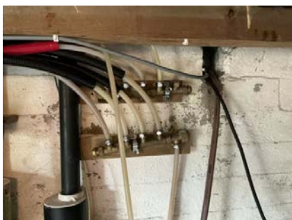
Vannledninger henger løst.
