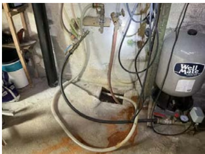
Vannledninger henger løst.
