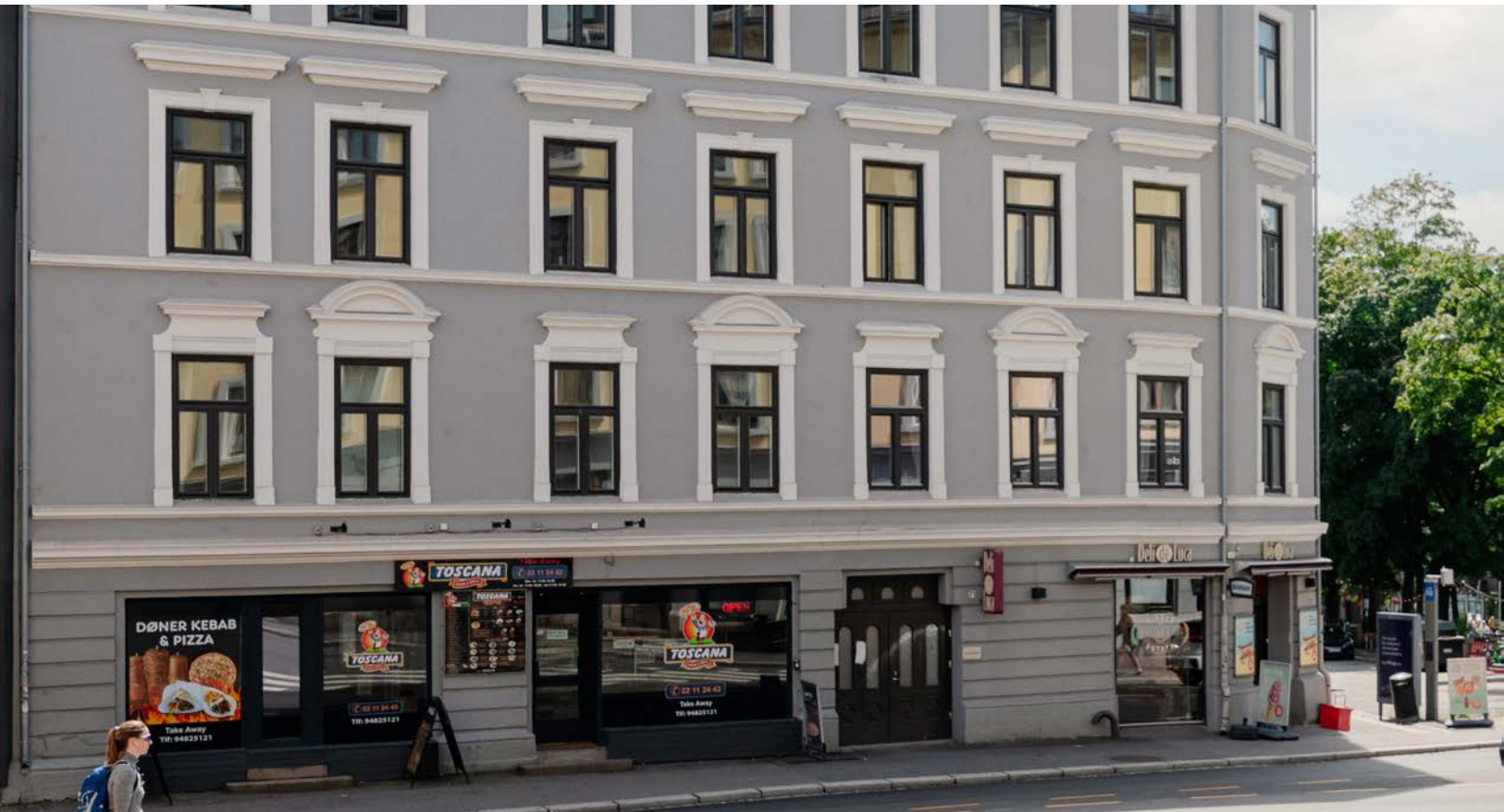
Bygården har en flott fasade.
