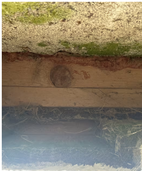
Viser lufting av kledningen og manglende musebånd.
