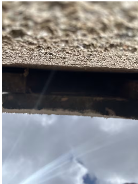
Viser lufting av kledningen og manglende musebånd.
