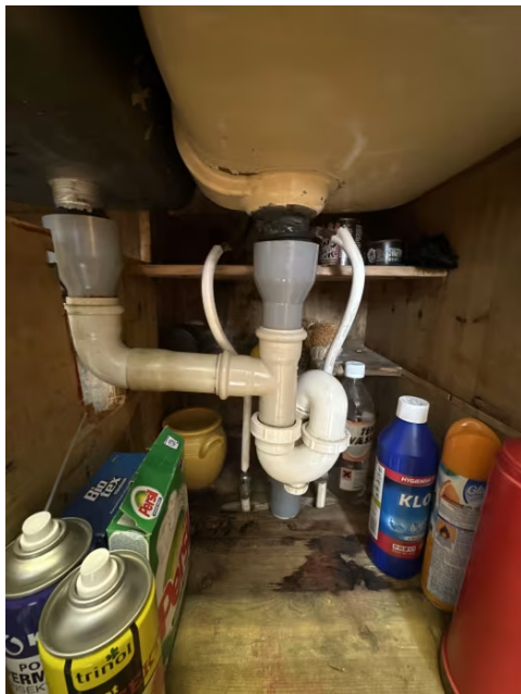
Viser vann og avløpsinstallasjoner under kum.
