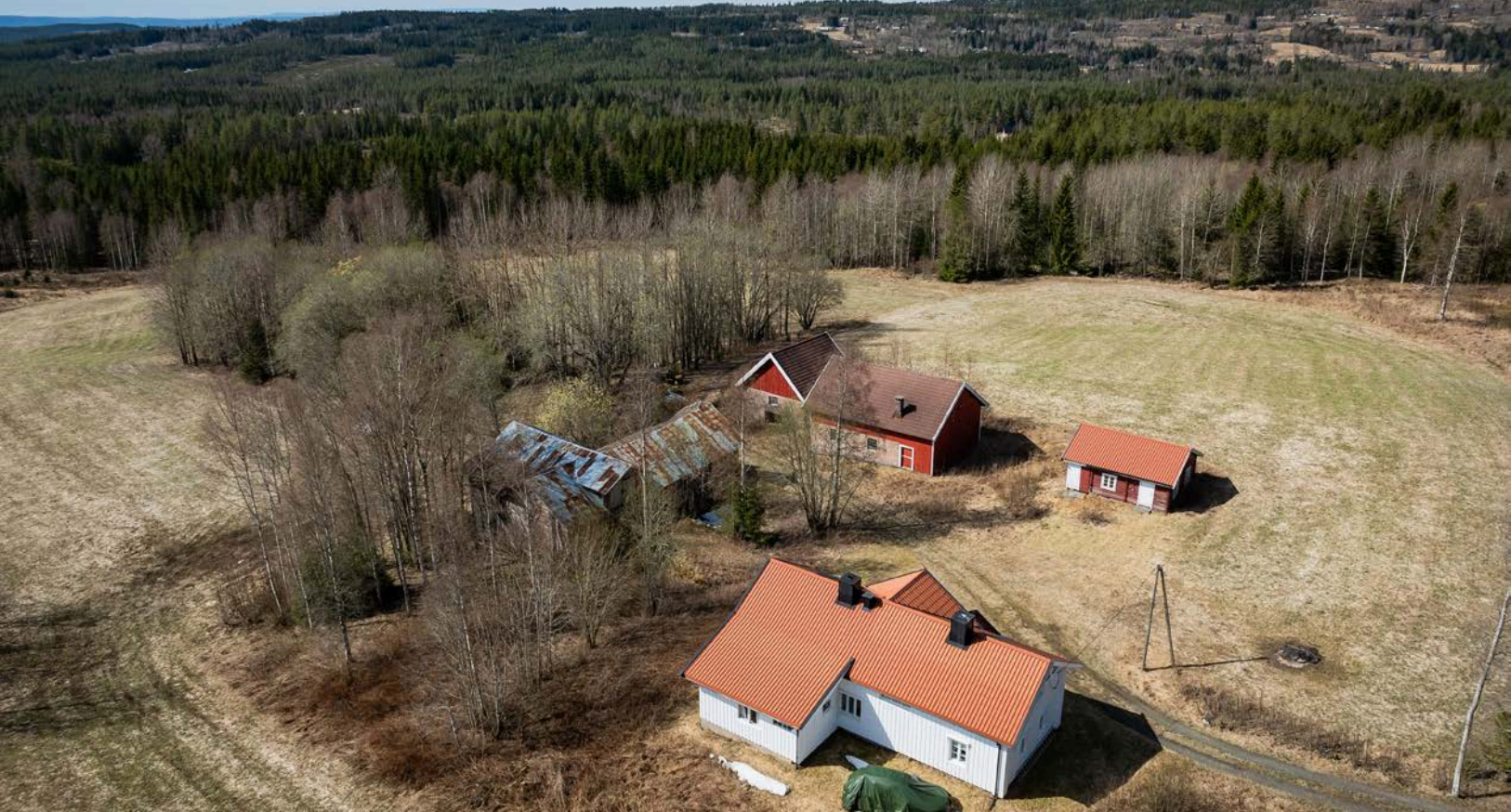
Tun med bebyggelse og landbruksarealer rundt bygninger.
