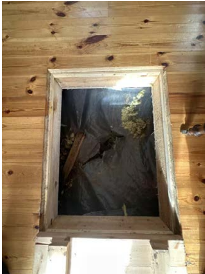
Viser adkomst til krypkjeller via luke i gulv i stue(eldre butikk)
