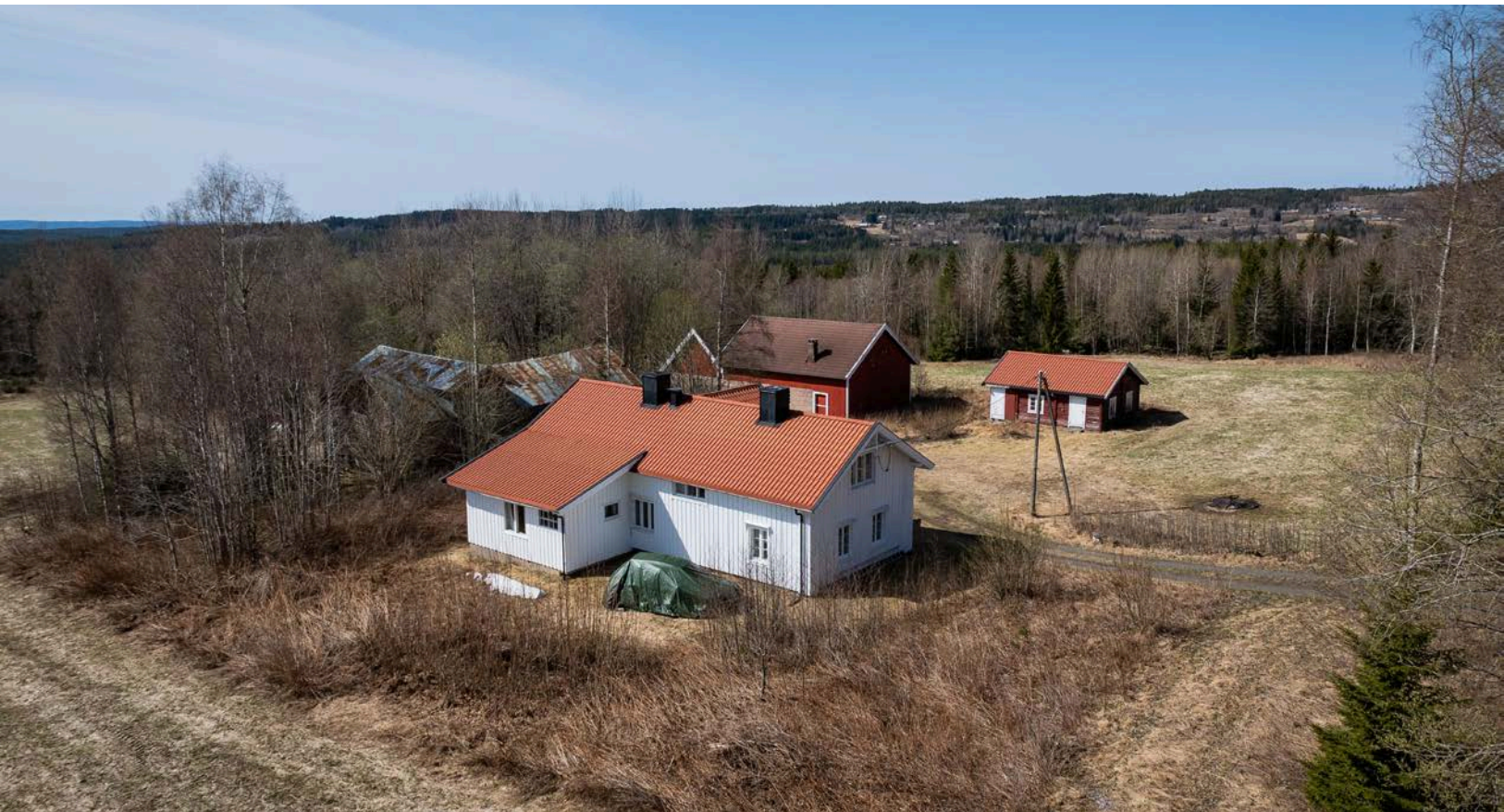
Eiendommen er også bebygd med en låve fra ca. 1900 med omfattende skader. Bygningen anses uten verdi.
