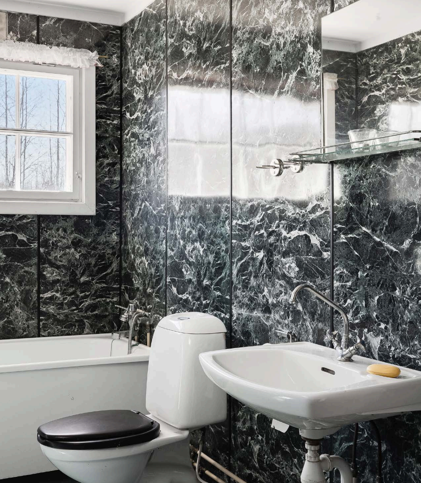
Baderommet har belegg på gulv og vegger med Respatex våtromsplater på veggene.
