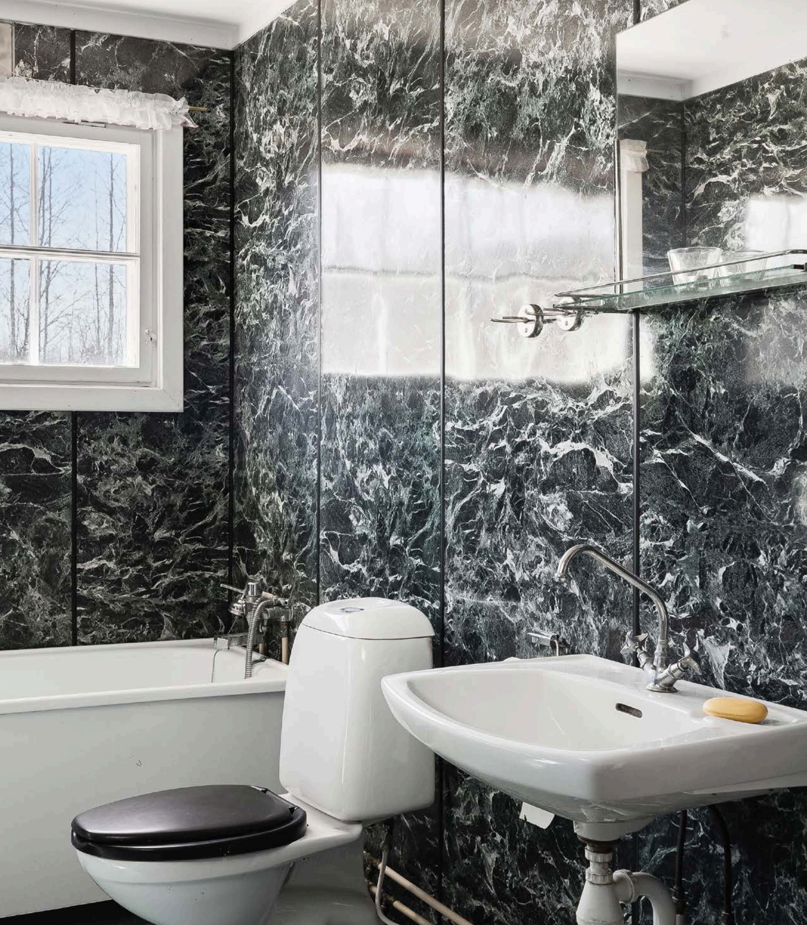
Baderommet har belegg på gulv og vegger med Respatex våtromsplater på veggene.
