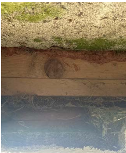
Det er stedvis benyttet klosser som musesperre bak kledning.
