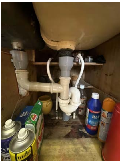
Viser vann og avløpsinstallasjoner under kum.
