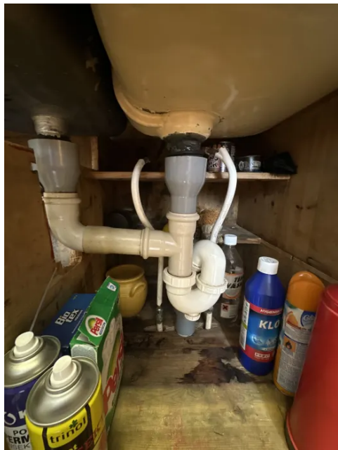
Viser vann og avløpsinstallasjoner under kum.
