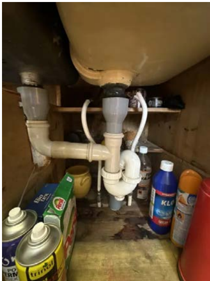
Viser vann og avløpsinstallasjoner under kum.
