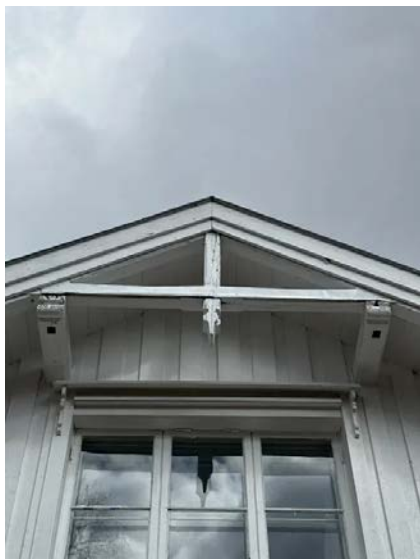
Det registreres stedvis råteskader ved mønekryss.
