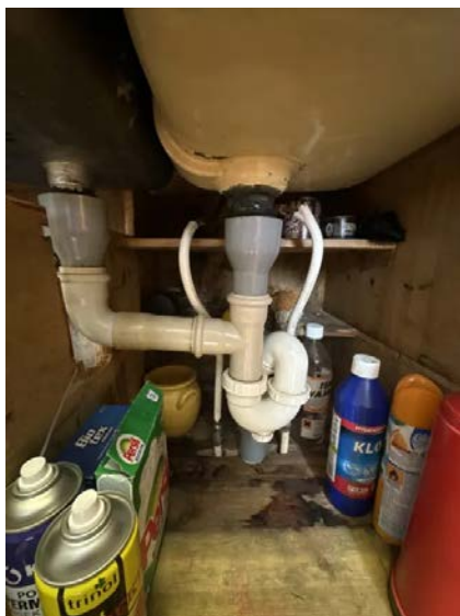
Viser vann og avløpsinstallasjoner under kum.
