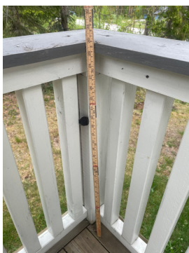
Mangler beslag i overgang yttervegg.
