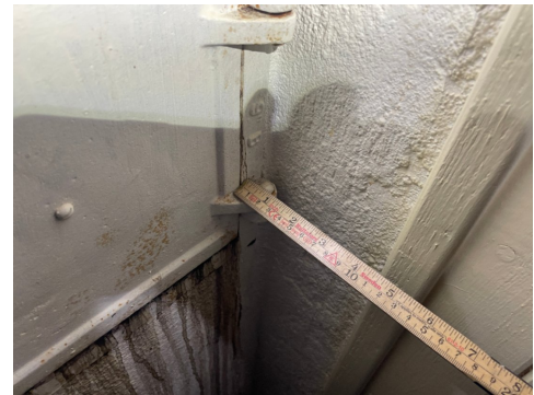
For liten avstand til brennbart materiale.
