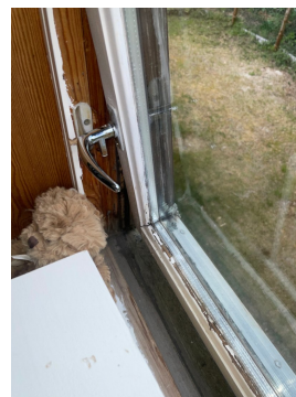
Værslitt og antydning til fuktighet i karmen.
