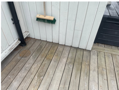
Mangler beslag i overgang yttervegg.
