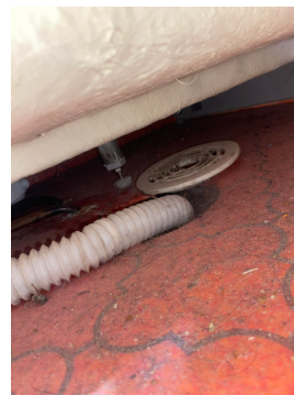
Ufaglig rørgjennomføring i gulv
