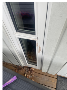
Værslitt og antydning til fuktighet i karmen.
