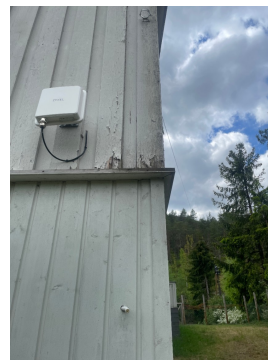
Påbegynnende råteskader i nedre del av kledningsbord.
