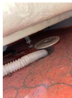
Ufaglig rørgjennomføring i gulv
