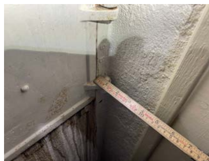
For liten avstand til brennbart materiale.
