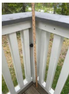
Mangler beslag i overgang yttervegg.
