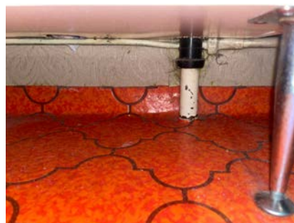
Ufaglig rørgjennomføring i gulv
