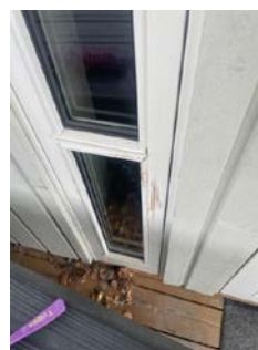
Værslitt og antydning til fuktighet i karmen.
