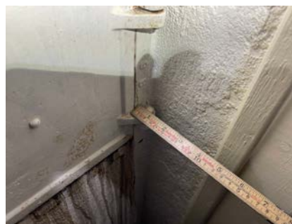
For liten avstand til brennbart materiale.
