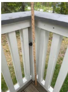
Mangler beslag i overgang yttervegg.
