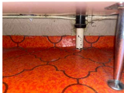
Ufaglig rørgjennomføring i gulv
