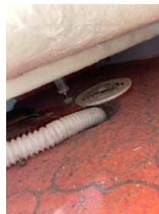
Ufaglig rørgjennomføring i gulv
