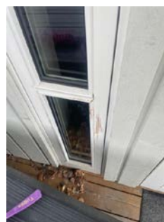
Værslitt og antydning til fuktighet i karmen.
