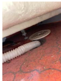
Ufaglig rørgjennomføring i gulv
