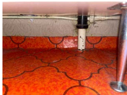
Ufaglig rørgjennomføring i gulv
