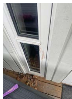
Værslitt og antydning til fuktighet i karmen.
