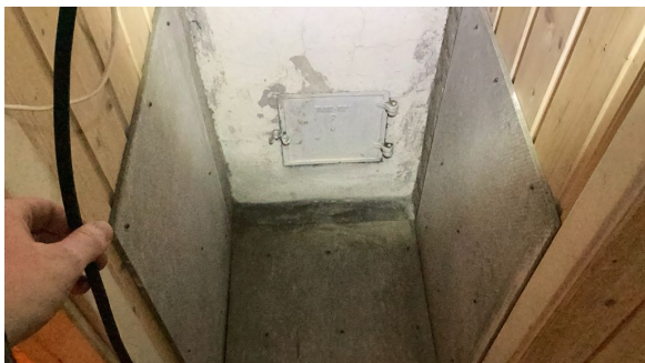
Feieluke lokalisert i underetasje.
