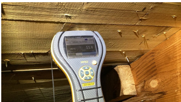
Ved enkel fuktmåling registrerte jeg tørre verdier.
