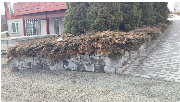
Bilde av mur.
