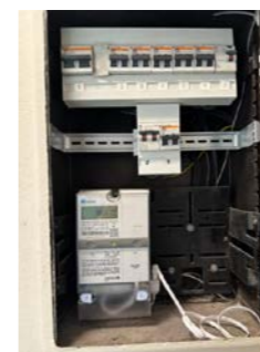
Sikringsskap med automatsikringer.
