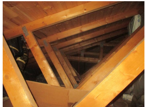
Takstoler med rupanel som undertak.
