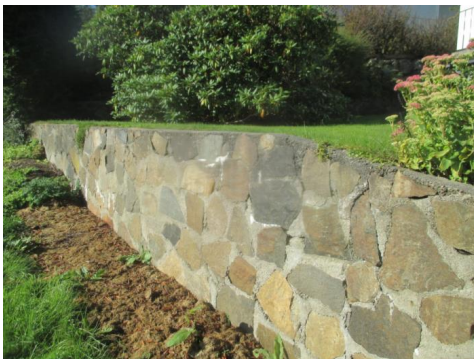
Natursteinsmur i mot friareal.
