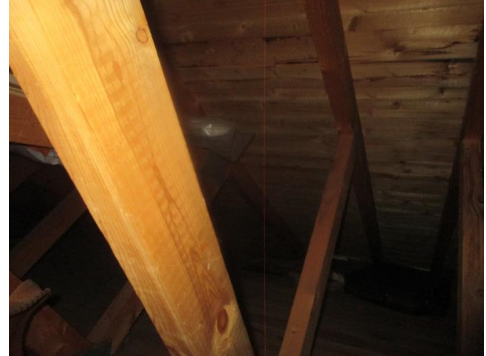
Deler av undertaket.
