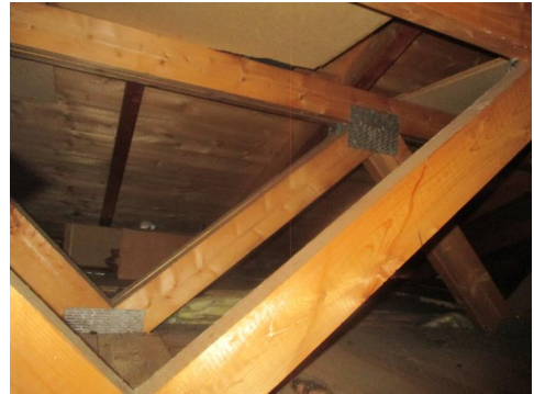
Deler av takkonstruksjonen.
