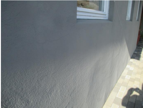
Deler av grunnmur.
