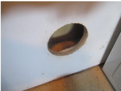
Hulltaking i vegg i mot gangen.
