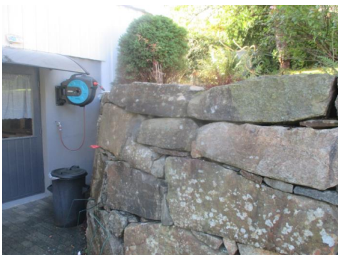
Maskinstablet forstøttningsmur.
