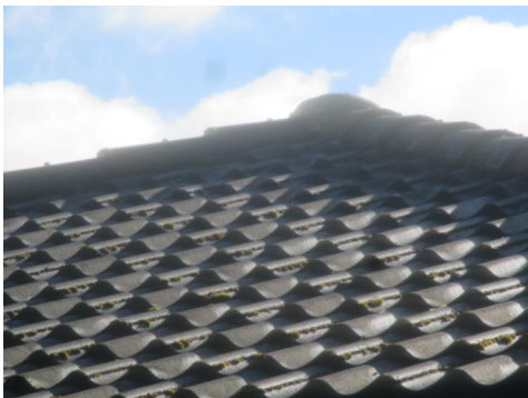
Deler av taktekkingen.
