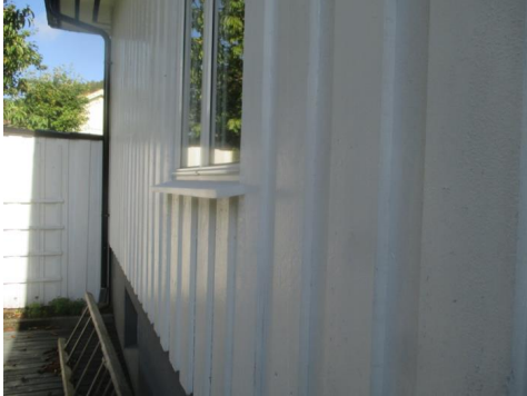
Deler av kledningen med tilhørende belistninger.
