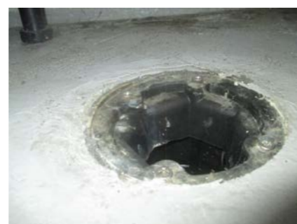
Sluk under innredningen.
