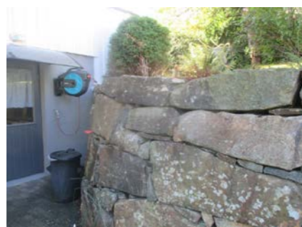
Maskinstablet forstøtningsmur.
