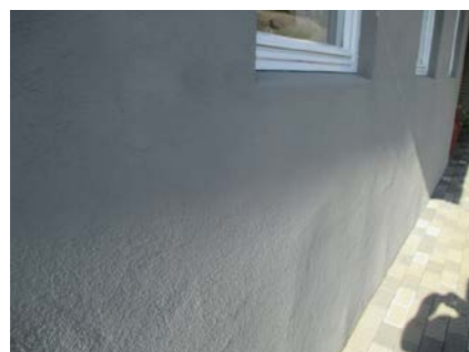
Deler av grunnmur.
