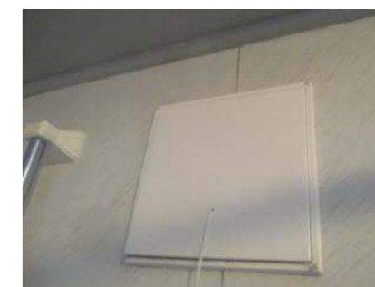
Ventil i grunnmur.
