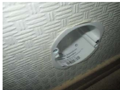
Hulltaking i fra toalettrommet.
