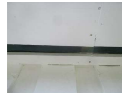
Gode luftespalter i gesimser.
