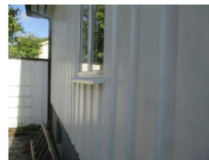
Deler av kledningen med tilhørende belistninger.
