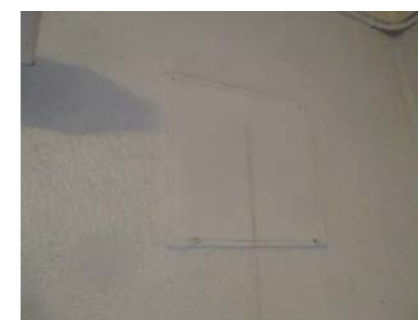
Ventil i grunnmur.
