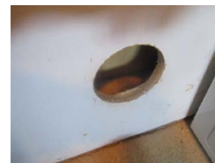
Hulltaking i vegg i mot gangen.
