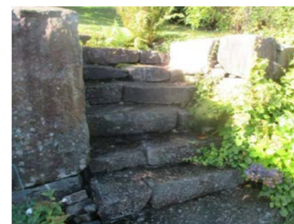
Trapp av større steinblokker.
