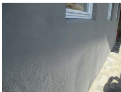
Deler av grunnmur.
