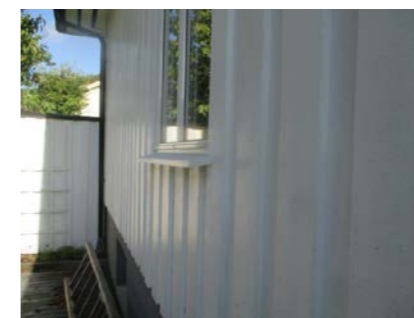
Deler av kledningen med tilhørende belistninger.
