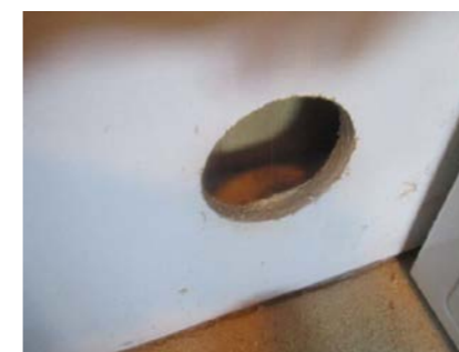
Hulltaking i vegg i mot gangen.
