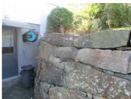
Maskinstablet forstøttningsmur.
