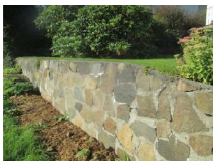
Natursteinsmur i mot friareal.
