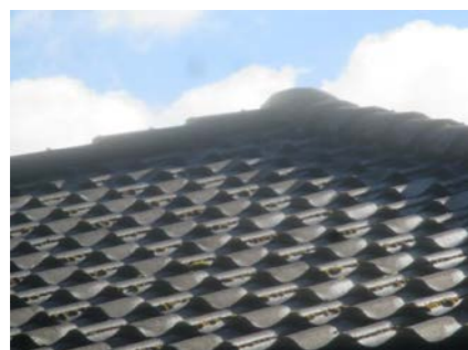
Deler av taktekkingen.
