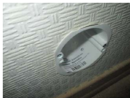
Hulltaking i fra toalettrommet.
