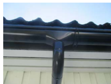
Takrenner og nedløp av stål.
