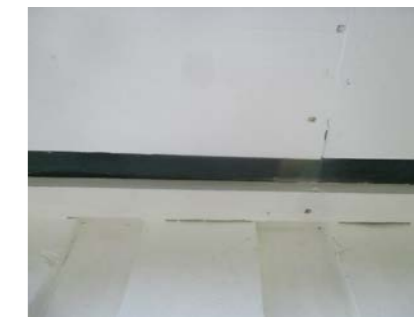
Gode luftespalter i gesimser.
