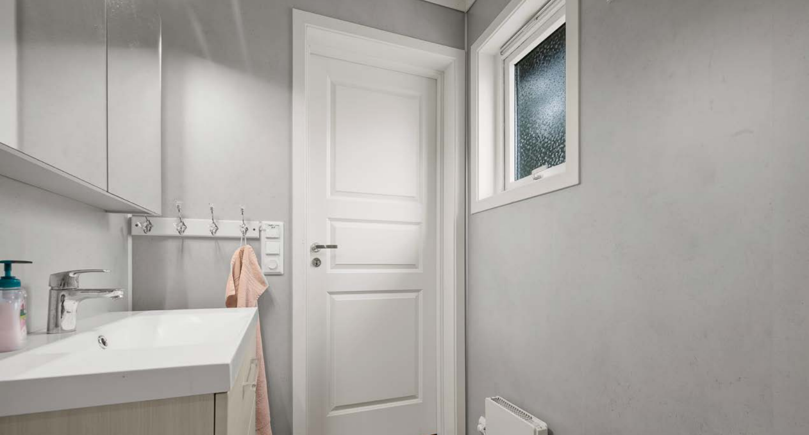
Badet ble renoveret i 2021 med belegg på gulv, våtromsplater på vegg og panel med spotter i himling.
