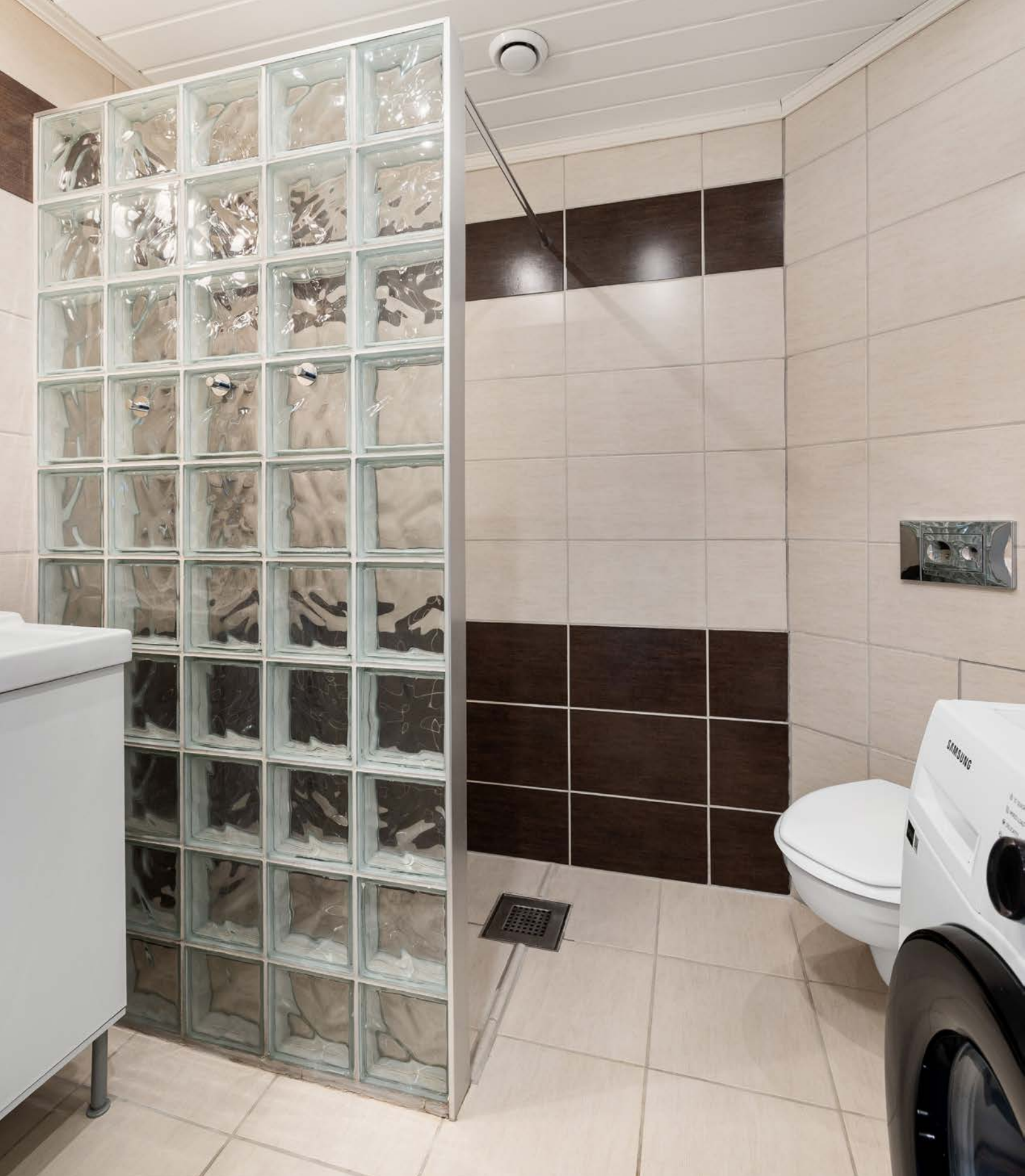
Flislagt bad med dusjnise med glassbyggerstein.
