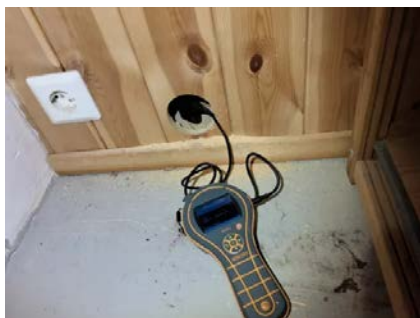
Bilde fra fuktmåling i veggkonstruksjon tilstøtende våtsone.
