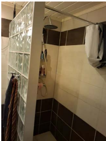
Dusjnise med veggheut dusjarmatur.
