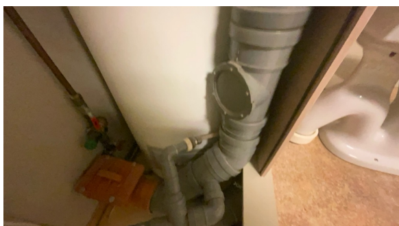
Del av rør til avløp.
