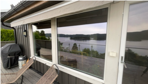
Eksempel på vindu i yttervegg.
