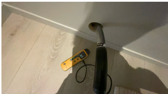
Hull for kontroll av fukt.
