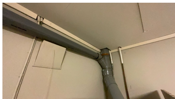
Del av rør til avløp.
