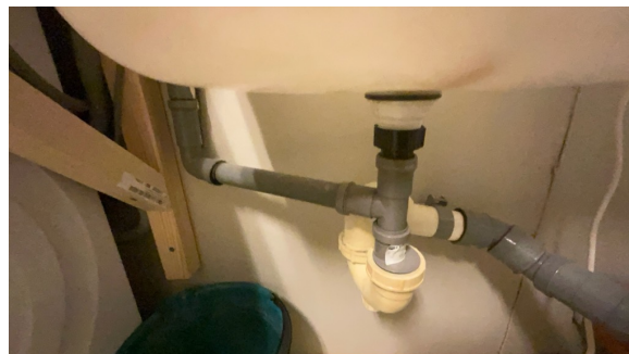
Del av rør til avløp.
