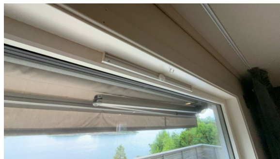
Eksempel på montert ventil i vindu.
