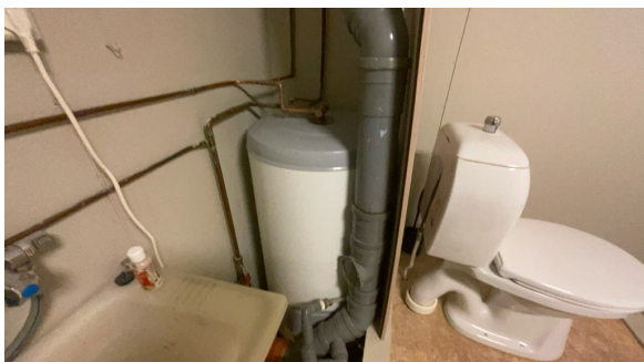
Varmtvannstank.
