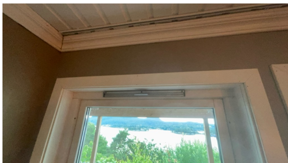
Eksempel på montert ventil i vindu.
