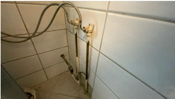
Del av rør til vann.
