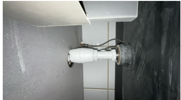
Del av rør til vann.
