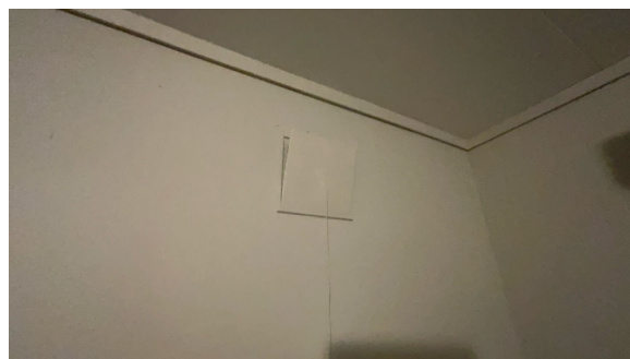
Eksempel på montert ventil i vegg.
