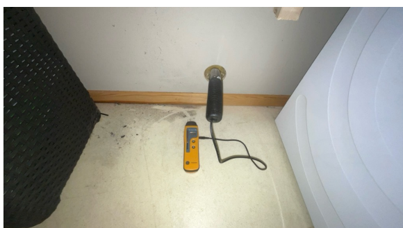
Hull for kontroll av fukt.
