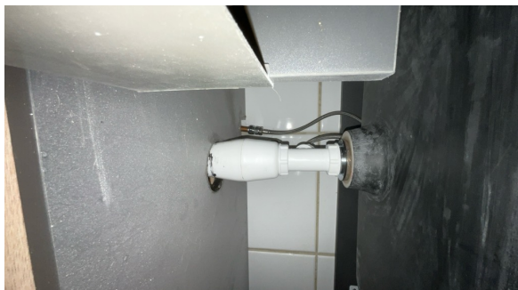
Del av rør til avløp.
