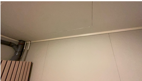
Del av vegg - tak.
