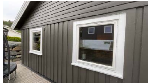
Eksempel på vindu i yttervegg.
