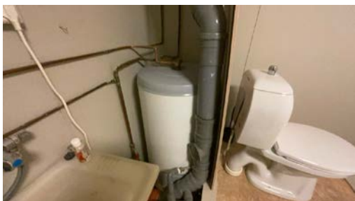
Varmtvannstank.
