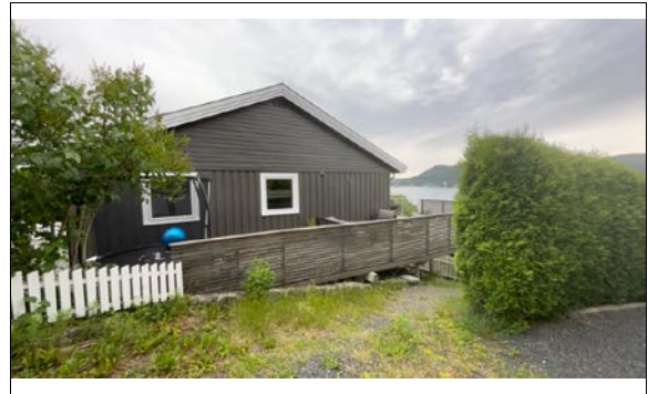
Leilighet oppført på eiendommen.
