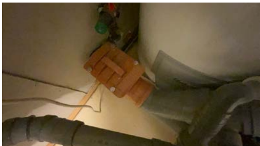
Avløpspumpe.
