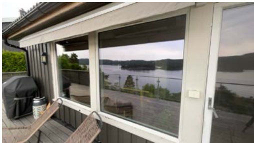
Eksempel på vindu i yttervegg.
