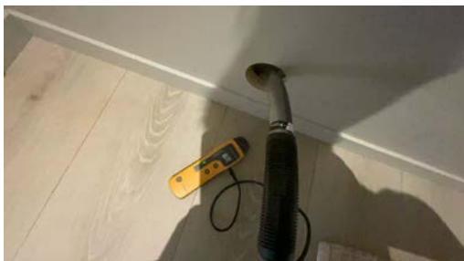
Hull for kontroll av fukt.
