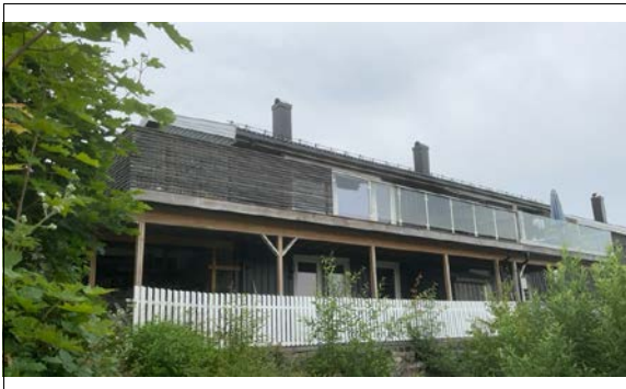
Leilighet oppført på eiendommen.
