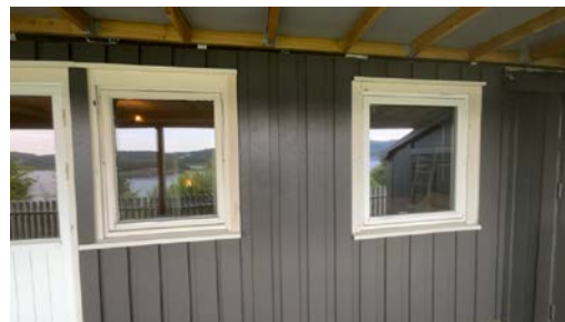
Eksempel på vindu i yttervegg.
