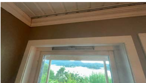
Eksempel på montert ventil i vindu.
