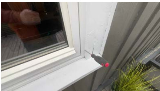
Stikkontroll på vinduer er utført.
