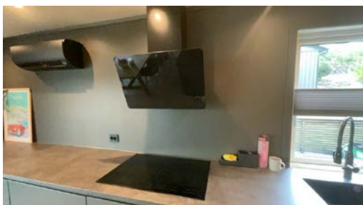
Montert avtrekk over steketopp.
