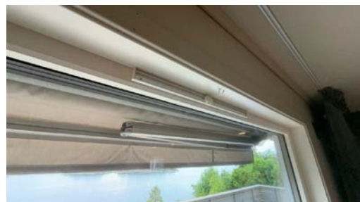
Eksempel på montert ventil i vindu.
