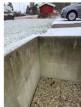
Bildet viser støttemur av betong.
