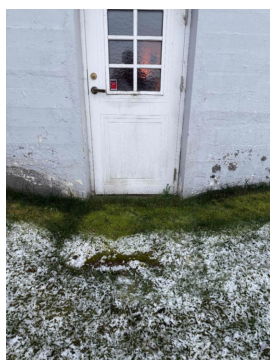
Bildet viser området foran inngangen til kjelleren.
