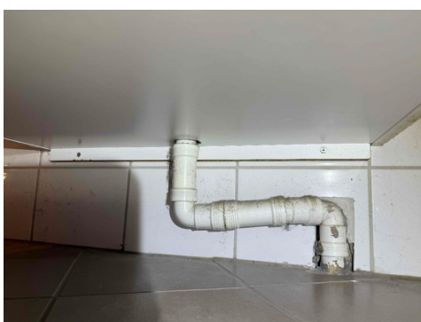
Bildet viser avløpet fra servanten med motfall.
