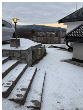
Bildet viser støttemur av betongstein og naturstein.
