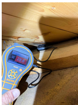
Bilder viser måling ved gradrenne på loft.
