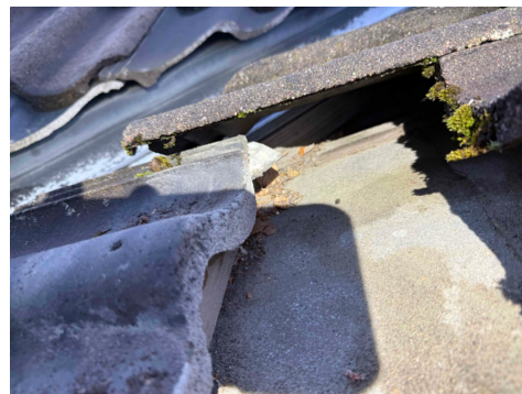
Bildet viser undertak ved gradrenne.
