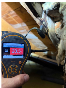
Bildet viser måling ved på loft ved pipe på hoveddelen.
