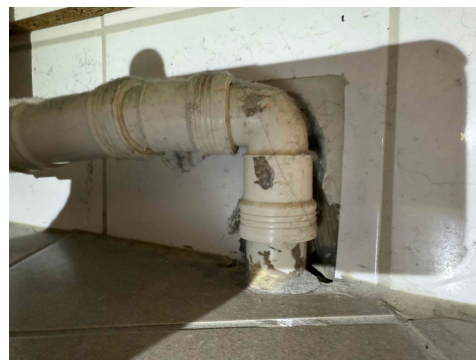
Bildet viser avløpsrøret fra servanten.
