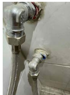
Bildet viser rørgjennomføring til dusjen.
