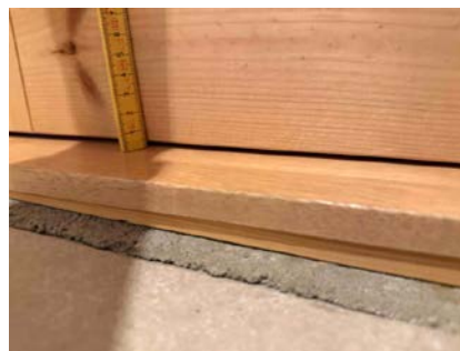
Bildet viser spalte mellom terskel og dørblad.
