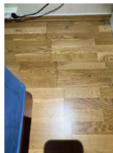
Bildet viser kjøter på parkettgulv med kort avstand.
