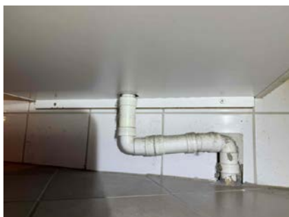
Bildet viser avløpet fra servanten med motfall.
