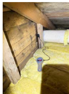
Bildet viser måling ved kanal i vegg fra kjøkkenventilator.
