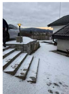
Bildet visere utvendig trapp i betongstein.
