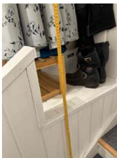
Bildet viser rekkverket øverst i trappen.
