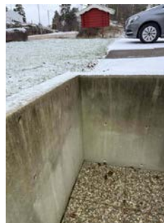
Bildet viser støttemur av betong.
