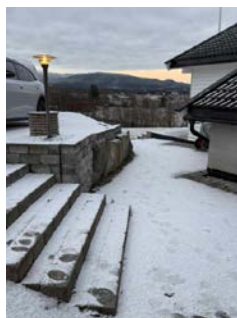
Bildet viser støttemur av betongstein og naturstein.
