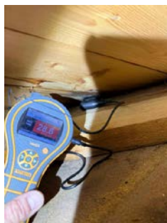
Bilder viser måling ved gradrenne på loft.
