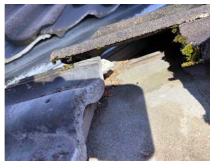
Bildet viser undertak ved gradrenne.
