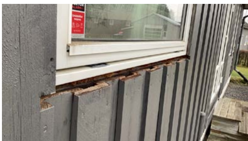
Det gjenstår å montere vannbrett på flere vinduer.
