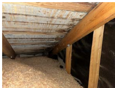
Oversikt fra loft. Stedvis mørke områder som kan minne om fuktmerker, kan stamme fra tidligere forhold.
