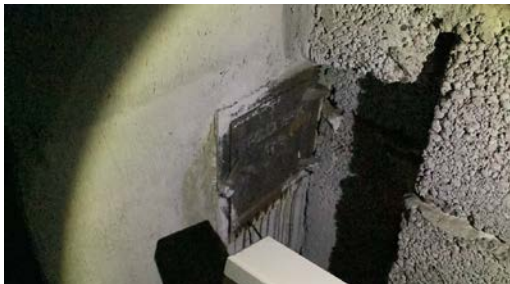
Sotluke i kjeller.
