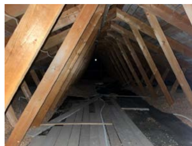
Oversikt fra loft. Stedvis mørke områder som kan minne om fuktmerker, kan stamme fra tidligere forhold.
